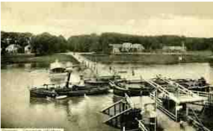
Een sloop vaart door de Schipbrug
