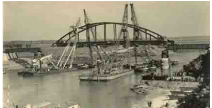
Inhijzen en opleggen van de brug
