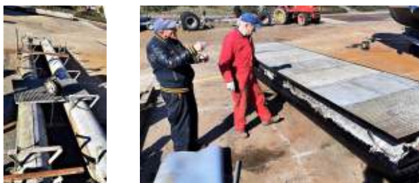
◀ Het vlot in aanbouw ▲ Kant en klaar
