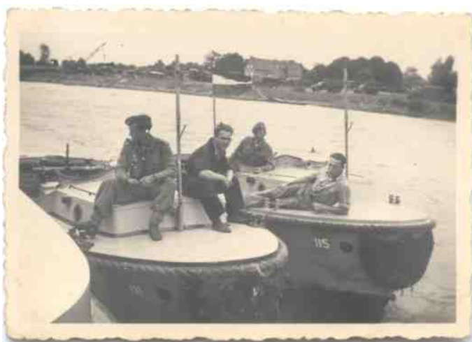
Schipper Jan Wieggers (3 e van links) die in 1952 "voor zijn nummer" bij de pontonniers diende
