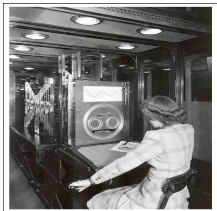
Een operator aan de getijdenmachine, die zij met haar linkerhand ronddraait. Zie het artikel in dit nummer.
