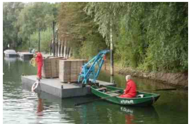
Ponton met 2 ton steenschotten
