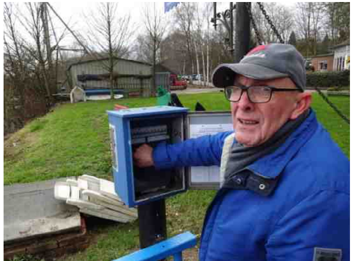
Hans schakelt de eerste keer de nieuwe elektrakasten in.
