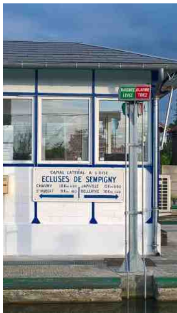
Zelfbedieningssluis Canal St Quentin
