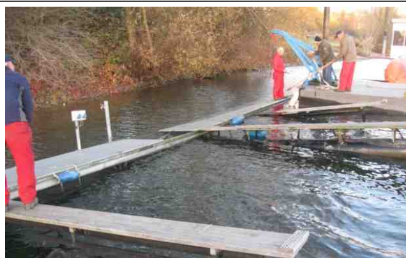
Dat zag er even niet goed uit... D-steiger gezonken. De 4 lekken(!) zijn inmiddels alweer gerepareerd.
