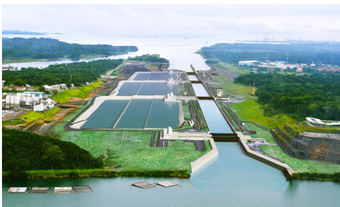
Maquette spaarsluizen Panamakanaal, Atlantic zijde
