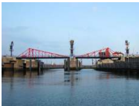
De Zuidersluis in IJmuiden.
