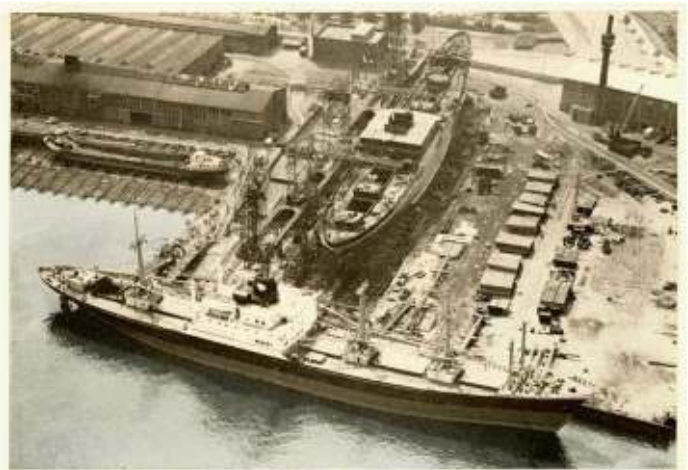
m.s. „STRAAT FRAZER“ van de N.V. Koninklijke Paketvaart-Maatschappij te Amsterdam. Gebouwd in 1963 door Machinafabriek en Scheepwerf van P. Smit Jr. N.V. te Rotterdam. Lengte 156,73 m. Breedte 29,42 m. Holte 12,19 m. 9.294 brt. Smit/B & W motor 12.100 pk. Snelheid 18 mijl. 62 Bemanningsleden.
