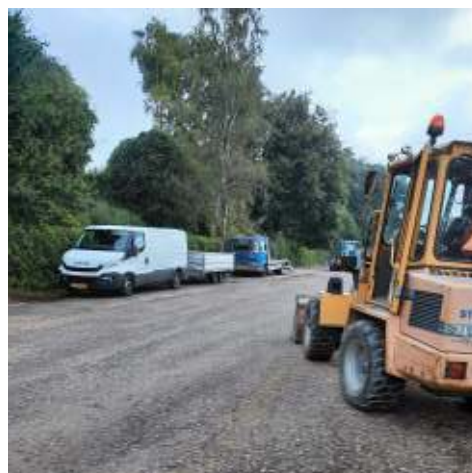
Terrein egaliseren en verharden
