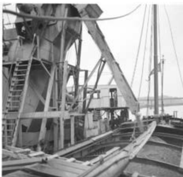
Zand laden bij de baggermolen
