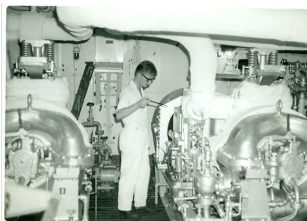
Oliepeil tandwielkast generator controleren
